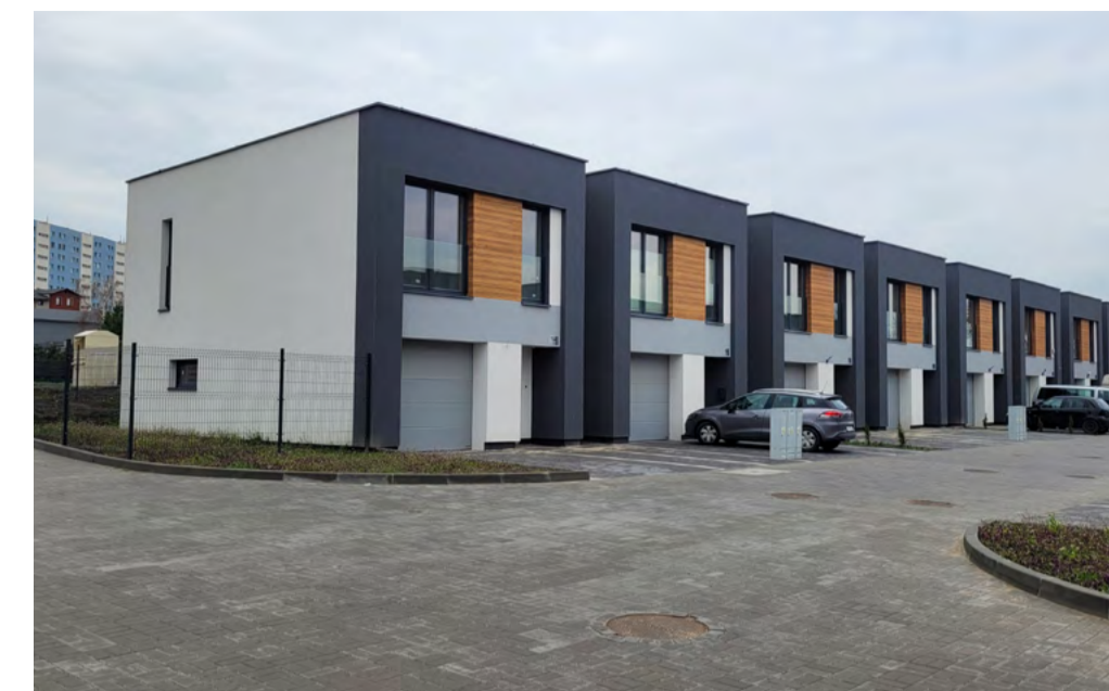
ul. Kozielecka - budynki podłączone do sieci ciepłowniczej
