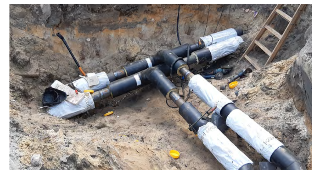
Budowa sieci ciepłowniczej w technologii preizolowanej
